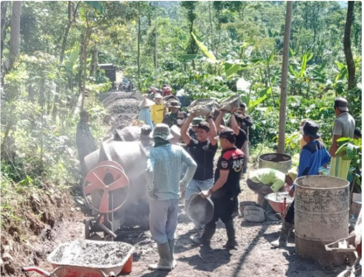
Satgas TMMD Kodim 0719/Jepara dibantu ormas Lindu Aji bergotong-royong dalam pengecoran jalan TMMD Sengkuyung Tahap II
